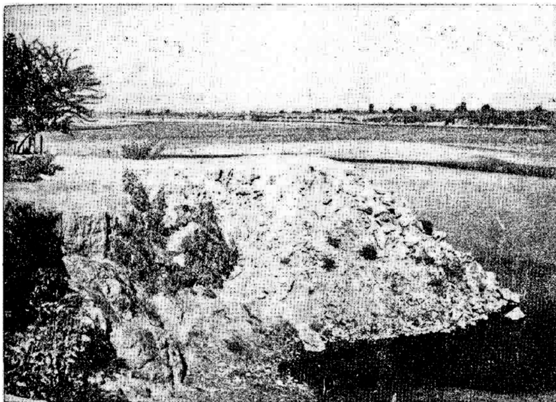
FIG. 10. Vista de un espigón construido para proteger de la erosión las márgenes del río.
