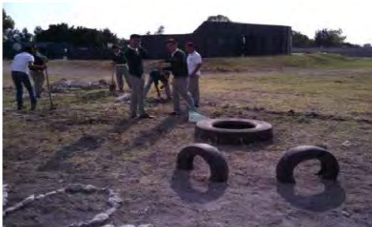
Figura 12. Construcción de jardineras con material de reuso.
