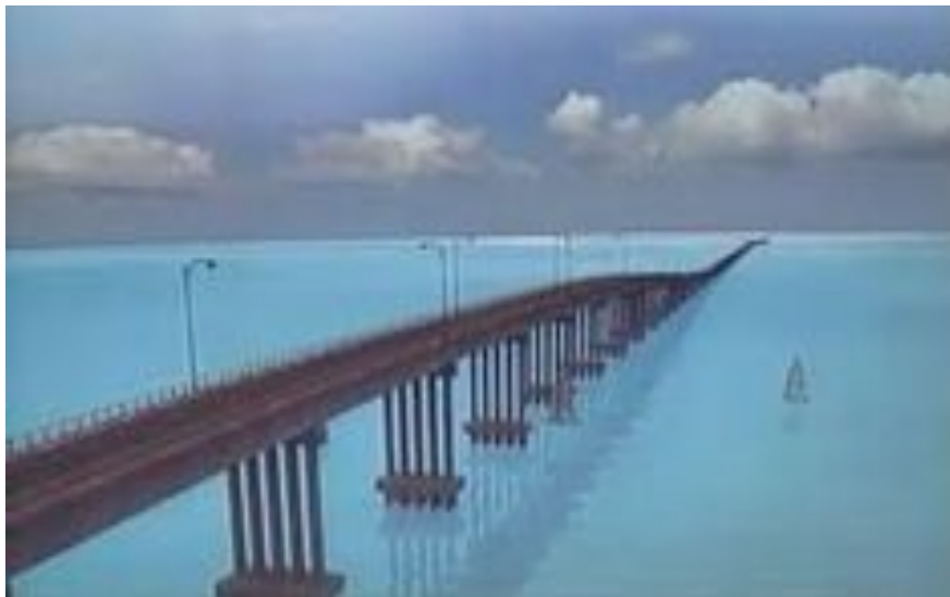
Imagen 1. Vista del puente de la Unidad.
