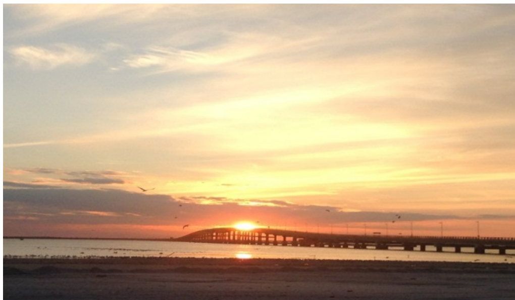
Imagen 2. Vista del puente El Zacatal.
