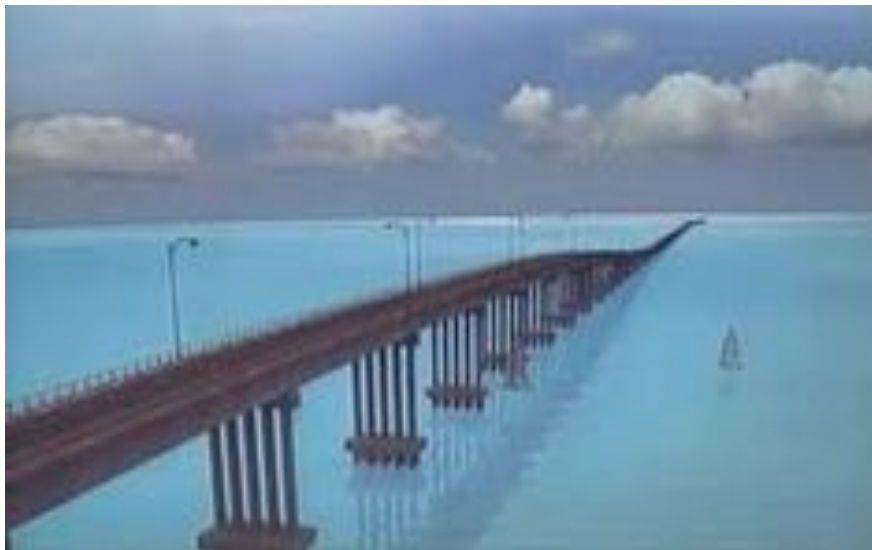
Imagen 1. Vista del puente de la Unidad.
