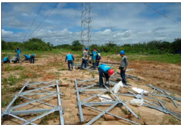
Figura 5. Montagem das torres de transmissão. Fonte: Parque Eólico Alegria (2011).
