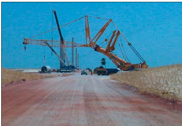
Figura 3. Etapa de instalação dos aerogeradores. Fonte: Parque Eólico Alegria (2011).
