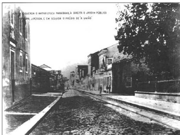
Figura 3. Rua Direita, Cidade da Parahyba, 1906. Na imagem identificam-se os lâmpioes afixados nas paredes externas do Colégio Liceu (a esquerda) e no edifício do Jornal A União, ambos situados na Rua Direita no entorno do Passeio Público com gradil de ferro da Figura 3. Fonte: Rodriguez (1962).
