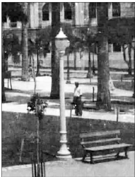
Figura 8.1. Detalhe da imagem da Praça João Pessoa. Poste padronizado em estilo simples iluminação elétrica.
