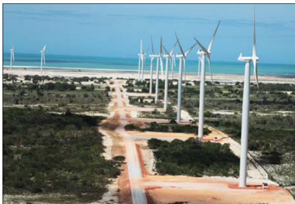
Figura 2. Parque eólico Alegria, Guamaré. Fonte: Parque Eólico Alegria (2011).
