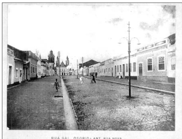
Figura 5.1 A paisagem retrata a Rua General Osório com passeios laterais e pavimentação. No centro da rua estão os postes de iluminação elétrica. O foco dá-se na direção da igreja matriz, posteriormente catedral. O casario sem recuo frontal e lateral permanece com as portas e janelas que permitem olhar a rua. Neste fragmento vê-se a introdução do equipamento moderno –a iluminação com energia elétrica– mantendo a tranquilidade da vida citadina, com pessoas na janela e na porta, poucas se deslocando. Fonte: Rodriguez (1962).
