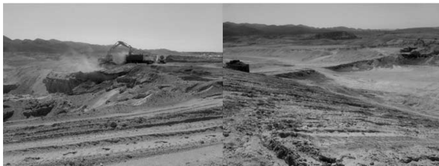
Figuras 8 y 9. Trabajos en el predio del Relleno Sanitario Regional.
