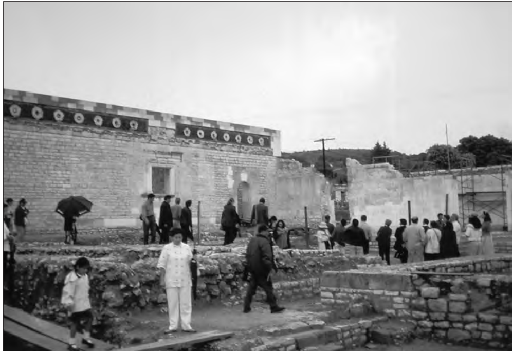
La casa de la cacica, construida alrededor de 1550, en restauración
