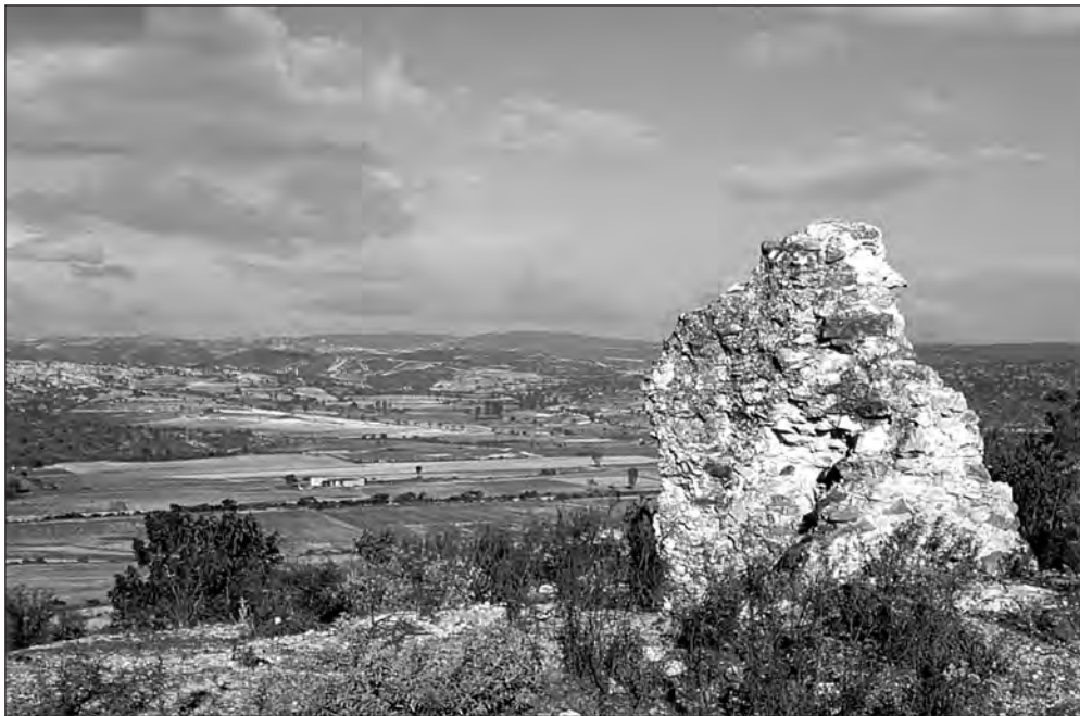
Muro que sobrevive de la iglesia vieja de Chachoapan, una de las estructuras religiosas coloniales más tempranas de la Mixteca
