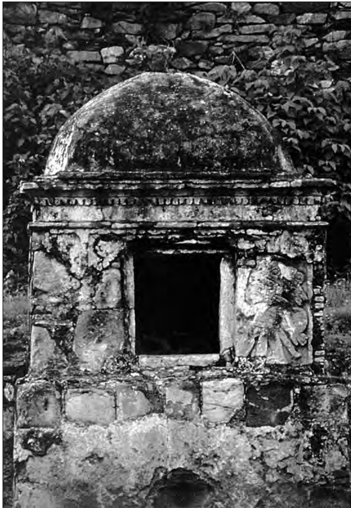
Toma de agua del acueducto del convento de Santo Domingo de Yanhuitlán que incorpora la imagen de un señor real mixteco en estilo prehispánico. Aproximadamente 1550
