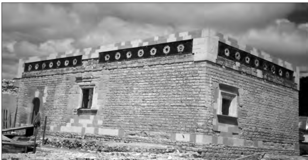
La casa de la cacica de Teposcolula, en restauración
