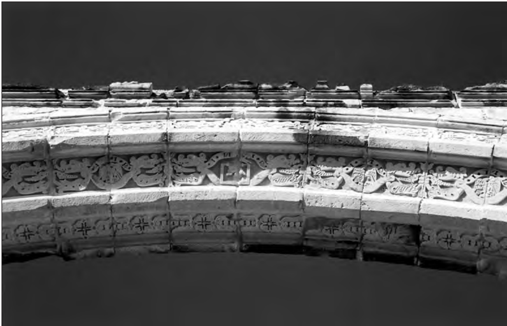
Capilla abierta, Coixtlahuaca (detalle)
