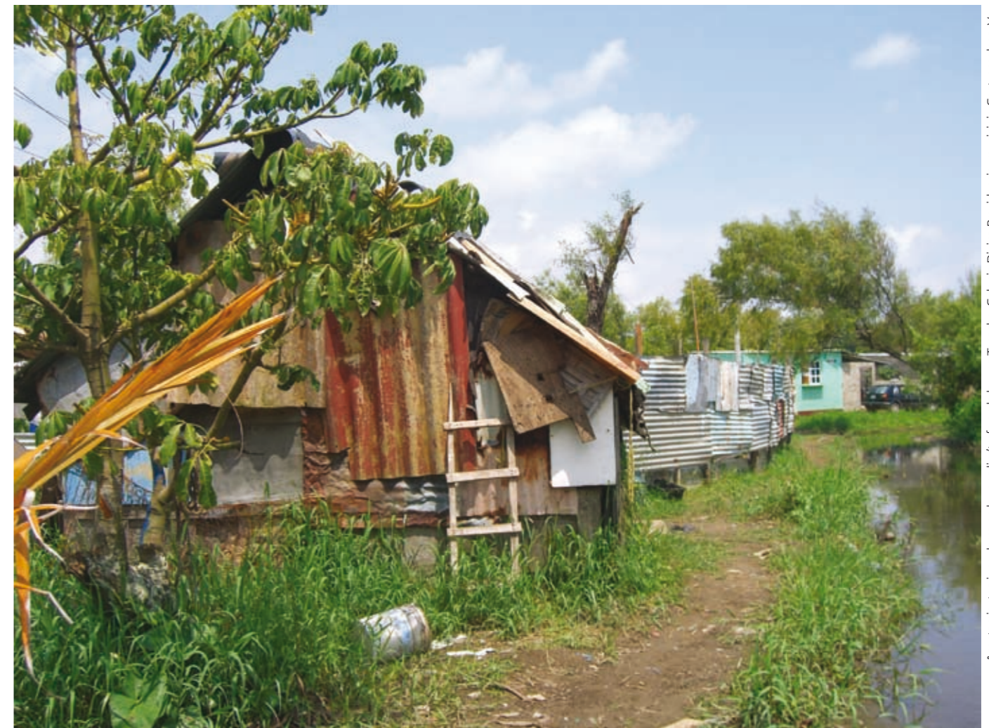
Asentamientos irregulares en la zona limítrofe en la laguna Tepache, Colonia Divina Providencia, municipio Coatzacoalcos, Ver. (cortesía de Mayelli Hernández)
