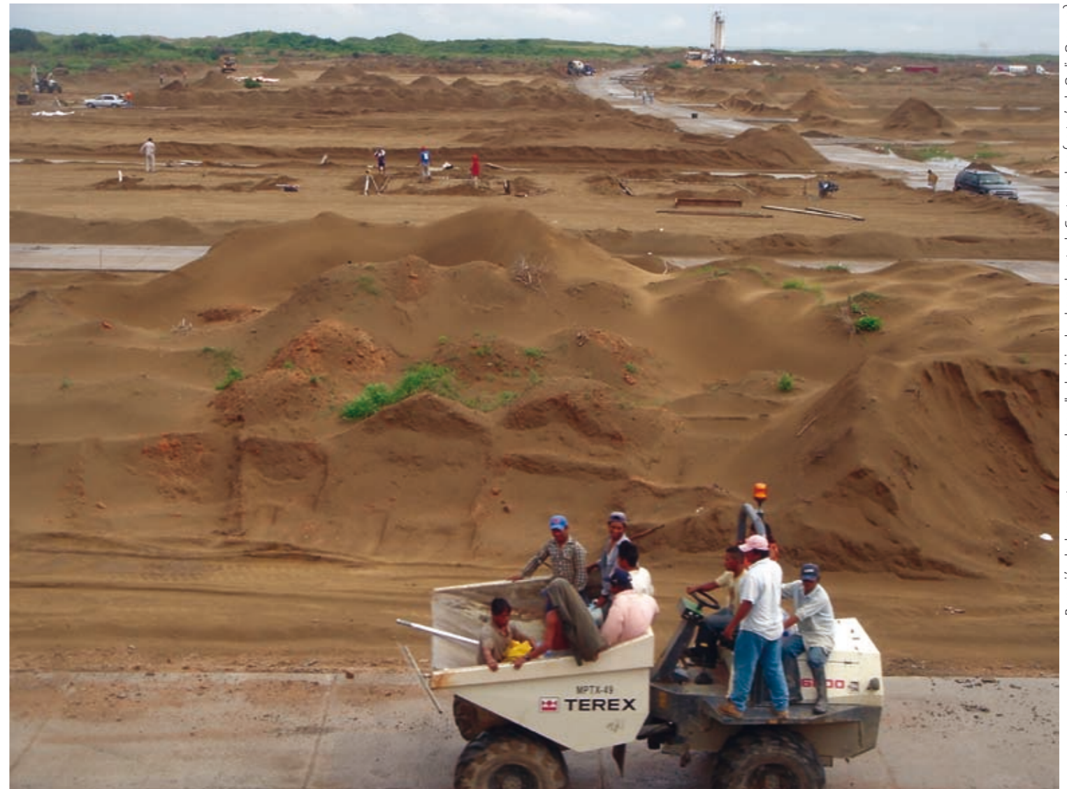
Remoción de dunas costeras para desarrollo de vivienda urbana al oeste de Coatzacoalcos (cortesía de Oraila Oropeza)
