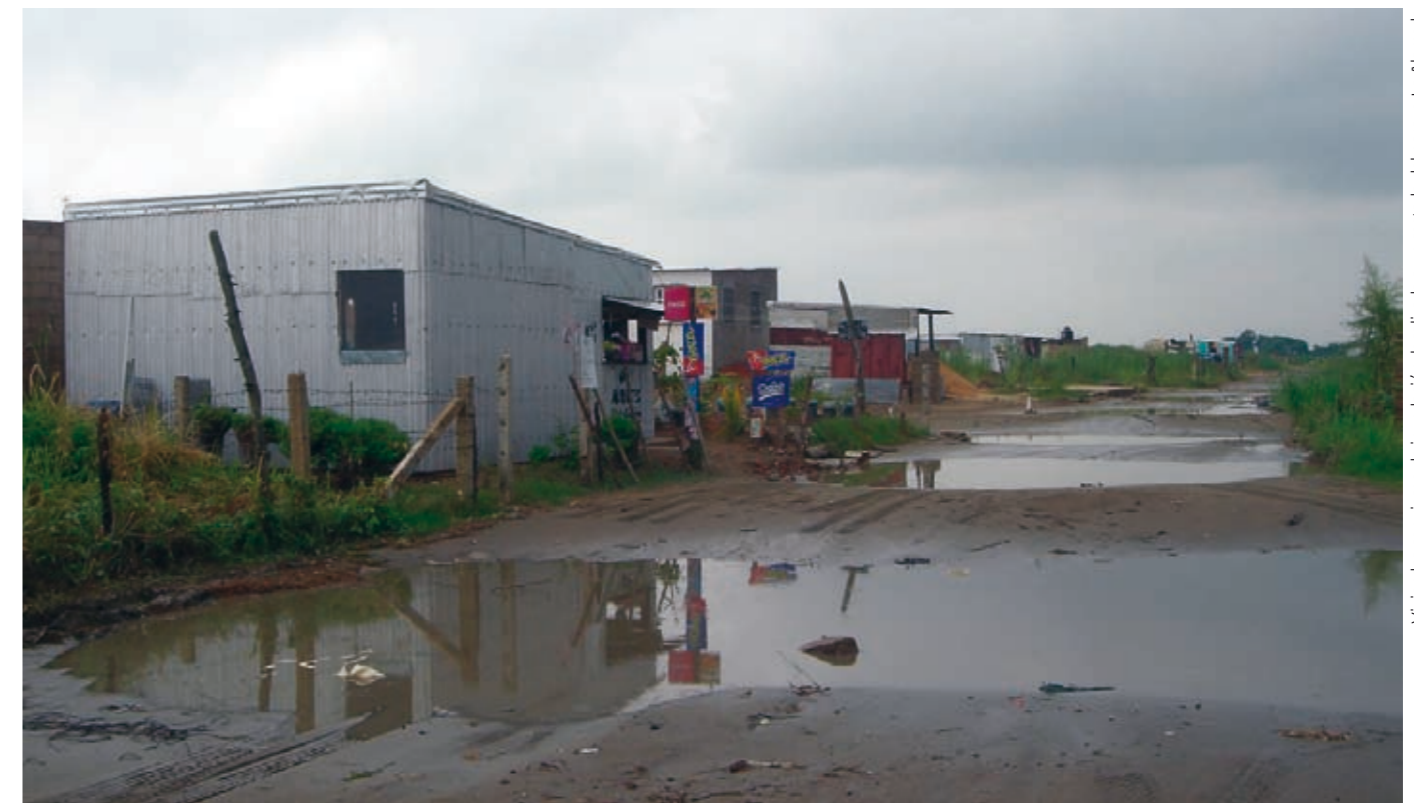
Viviendas con riesgo de inundación, localizada a un costado del parque La Alameda (cortesía de Mayelli Hernández)
