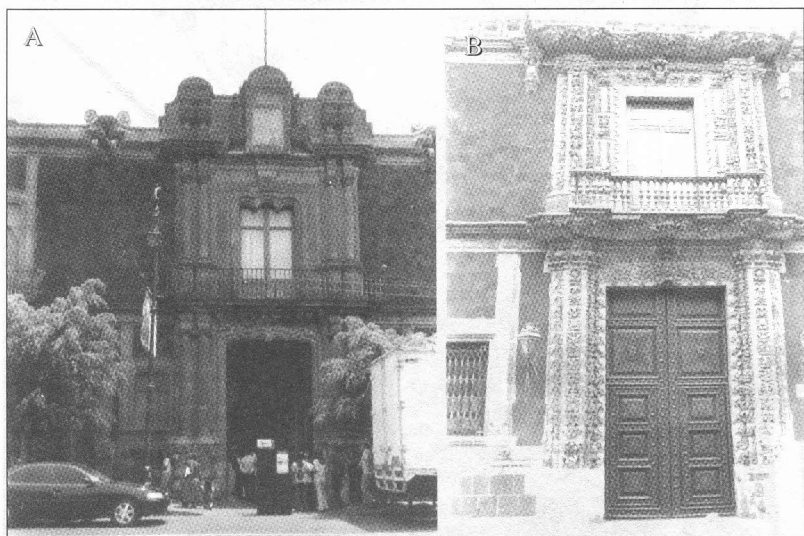
Figura 45. Edificios habitacionales del siglo XVIII. A. Palacio de los Condes de Calimaya. Actualmente Museo de la Ciudad de México, ubicado en las calles de Pino Suárez y República del Salvador. B. Casa de los Condes de Heras, construida por el platero Adrián Ximenez en 1760 y habitada en el siglo XIX por el último conde de Heras (fotos: JGS y MTGM).
